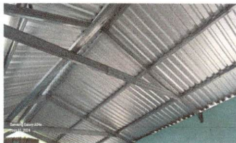
Foto 4: Terminacion del techado, aula numero 7
