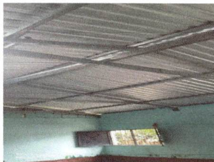
Foto 2: Terminacion del techado . Aula No. 6
